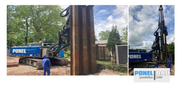
Tür auf - Spundwand frei! Denn der Bauherr und Auftraggeber Immobilien Gerstmeier baute in Aurich eine neue Wohnanlage. Im Juli 2022 wurde das Projekt umgesetzt. Mehrere Spundwände wurden erschütterungsfrei in die Erde gepresst. Das Team arbeitete an einer frei eingespannten Spundwand.
